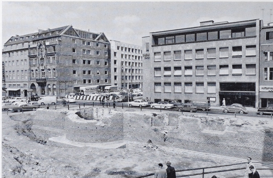
14 Köln. Südfront von der nördlichen Stadtmauer der CCAA mit Turm an der Komödienstraße / Ecke Tunisstraße.
