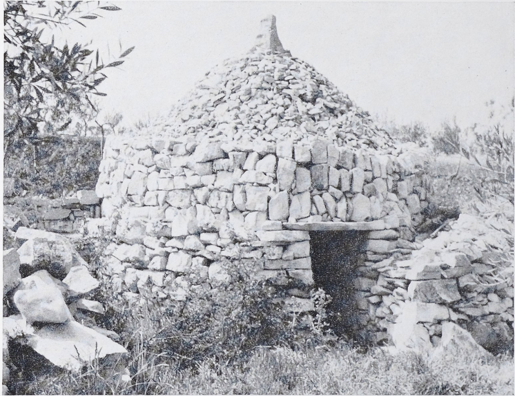
27 Gartenhütte (trullo) bei Canosa. Tür mit extrem dünnem Sturz, durch die senkrechte Steinschichtung hoch belastet.
