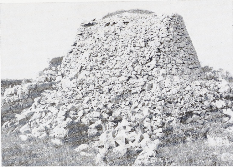
18 Teilzerstörter Mantelbau bei Sta. Cesárea, Apulien.
