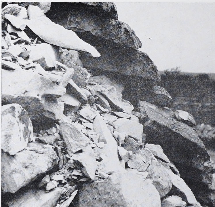
24 Dacheindeckungsdetail eines teilzerstörten Wohnhauses bei Conversano, Apulien.
