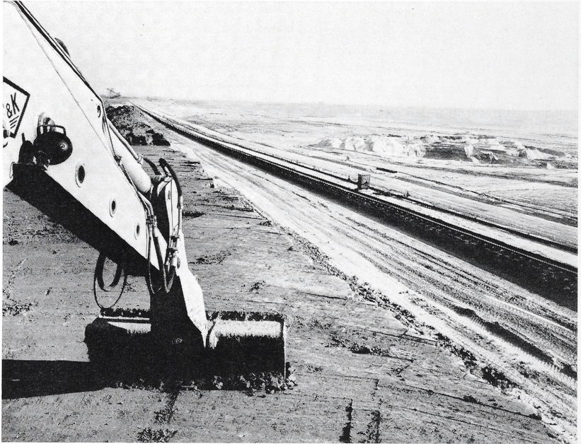
2 Aldenhovener Platte. Planieren mit der Baggerschaufel.
