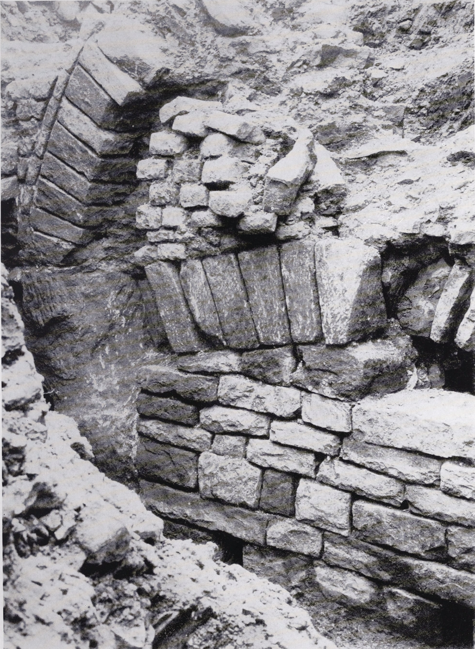
Innenseite der Nordwestwand der römischen Brunnenstube am Klausbrunnen bei Kallmuth.
