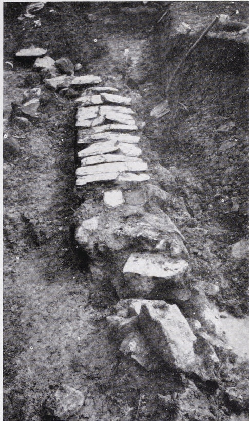
Abb. 2. Quellfassung des Gleueler Stranges.
