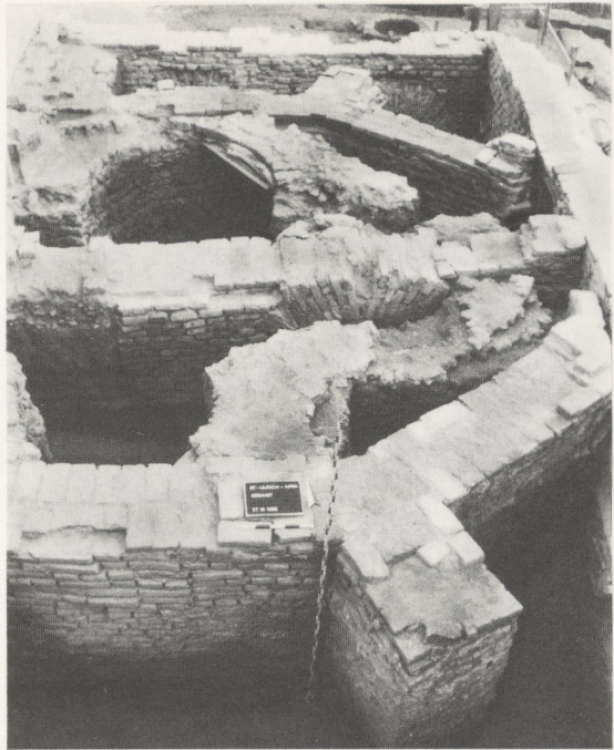
91 Augsburg, St. Ulrich und Afra. Blick auf den aus Tuff gebauten Dreikonchenchor der Kapelle St. Jakob mit dem gotischen Chorabschluß aus Ziegeln.
