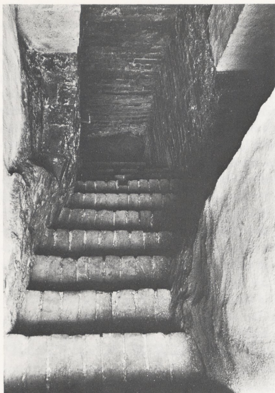
130 Regensburg, jüdisches Ritualbad. Treppenabgang zur Mikwe mit Felsenwanne. Die verputzten Sockel gehören zur modernen Stützkonstruktion.
