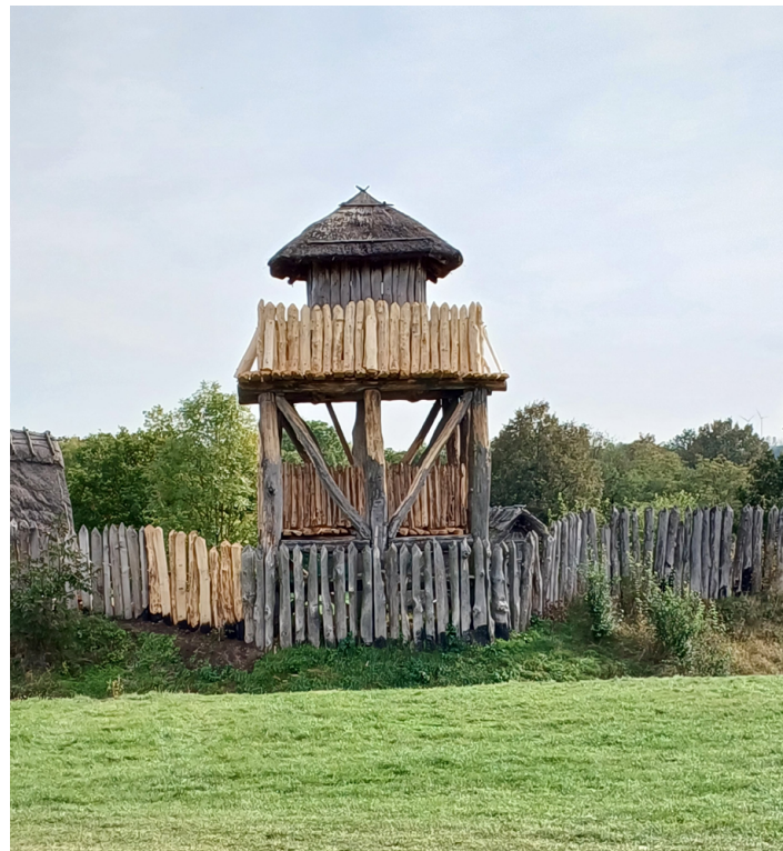
Abb. 6 Frisch restaurierter Wehrturm auf der Funkenburg. Jahr für Jahr sind werden neue Abschnitte der insgesamt 650 m langen Palisadenumfassung repariert und ausgetauscht. Foto: Freilichtmuseum Funkenburg, R. Müller/S. Bendeleben.
