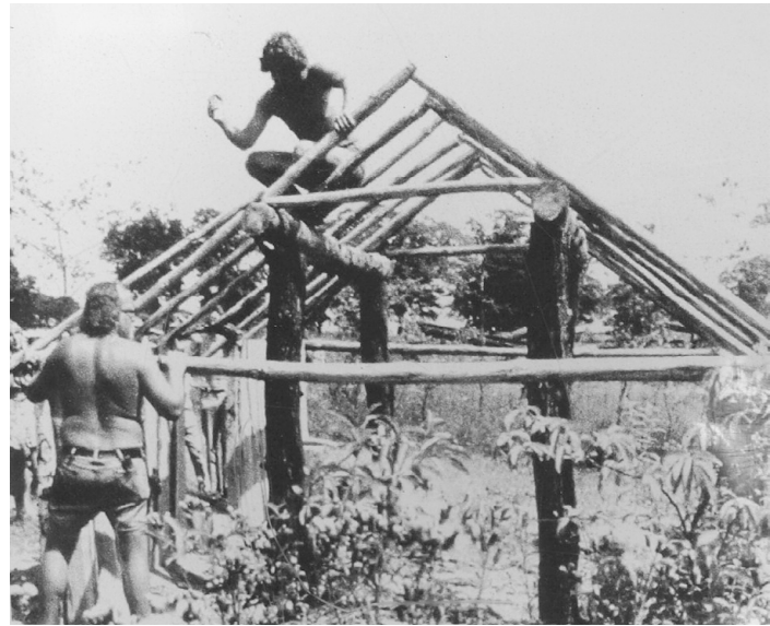
Abb. 7 Bau des ersten Hauses im Museumsdorf Düppel – 1973. © Förderverein Museumsdorf Düppel e. V.
