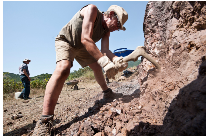
Schlägel- und Geweihhackenarbeit bei den Feuersetzexperimenten im Goldbergbau von Sakdrissi (2011). Foto: DBM, AVttention, K. Stange.
