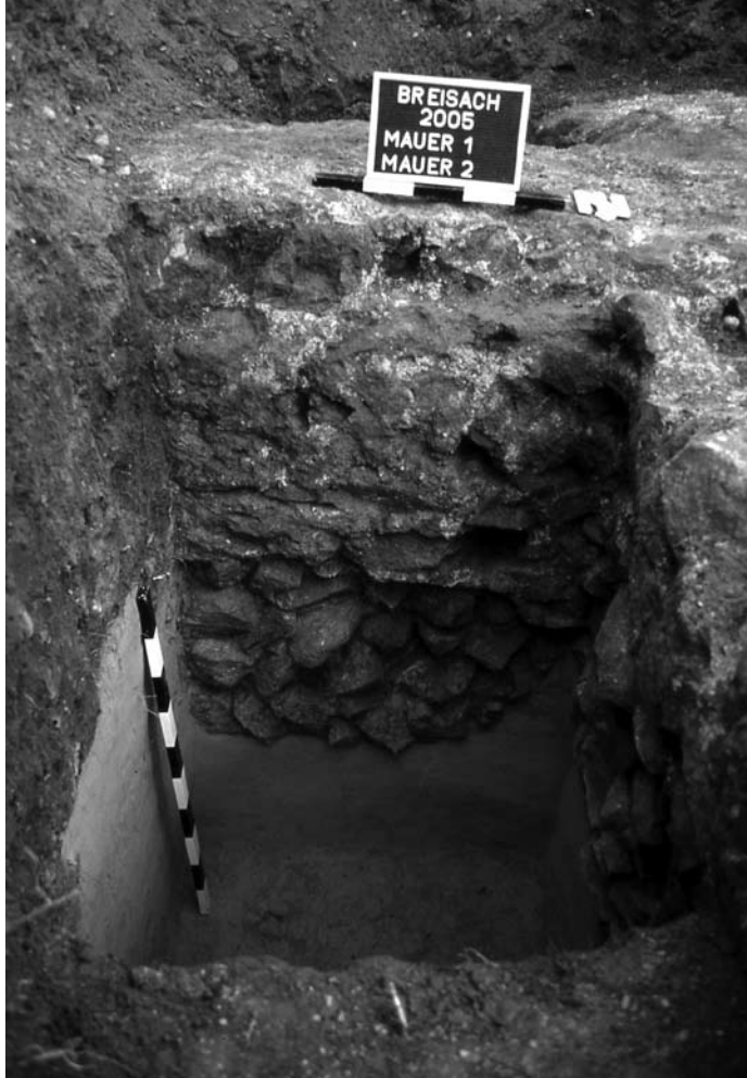
Abb. 4. Profilschnitt an der römischen Mauer. Zu erkennen ist der Aufbau des Fundaments aus Bruchsteinen, die ohne Mörtelbindung in den Löß gesetzt sind. Darauf folgen mehrere Lagen vermörtelter Fundamentbereich.
