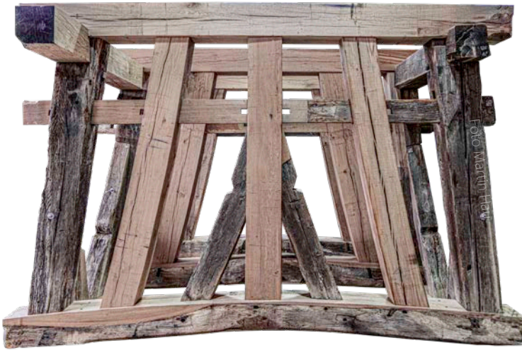
Abb. 2 - Vormontage des oberen Stockwerks in der Werkshalle im Januar 2021
