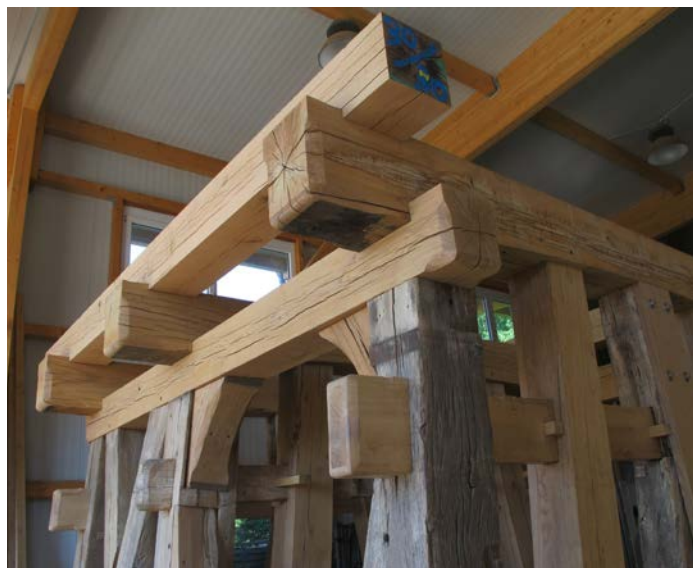
Abb. 1 - Vormontiertes mittleres Stockwerk in der Werkshalle mit neuem Eichenholz.
