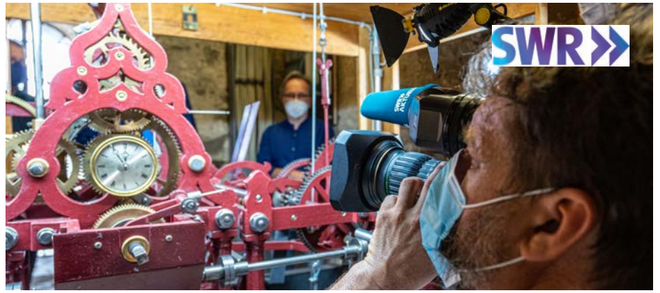
19. Juni 2021 - das SWR Fernsehen berichtet von der Inbetriebnahme der Kirchturmuhre
