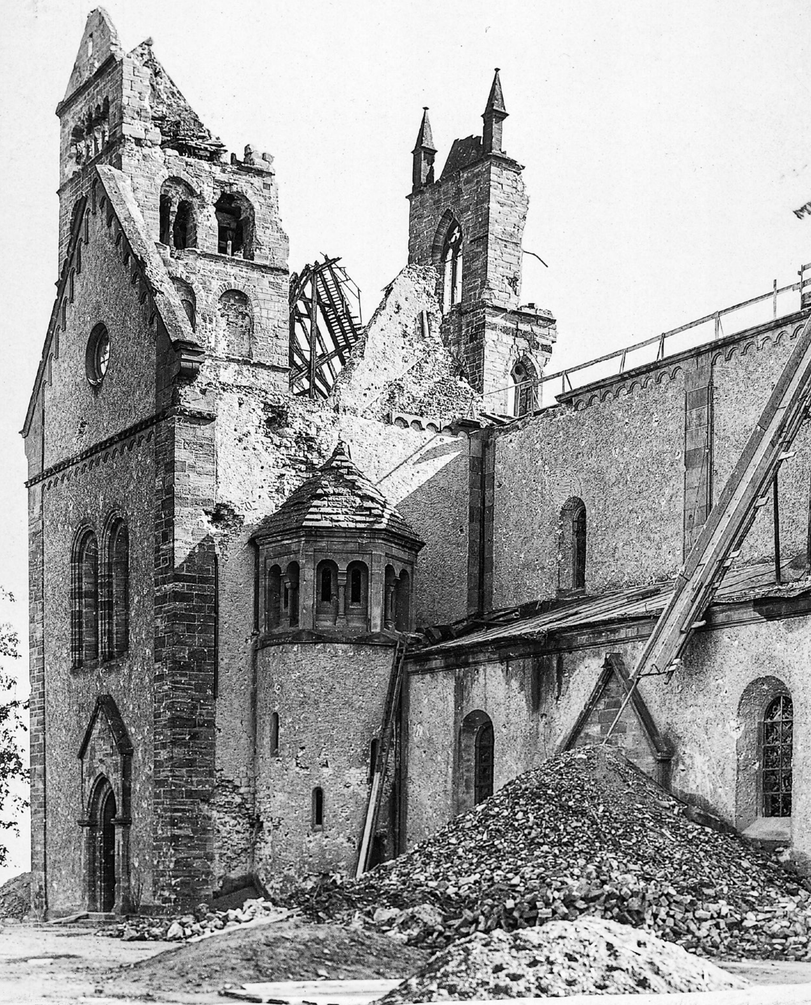
Die schwer beschädigten Turmhelme nach den Bombardierungen
