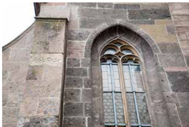
Abb. 25: Die Ostwand der Sakristei des Breisacher Münsters.
