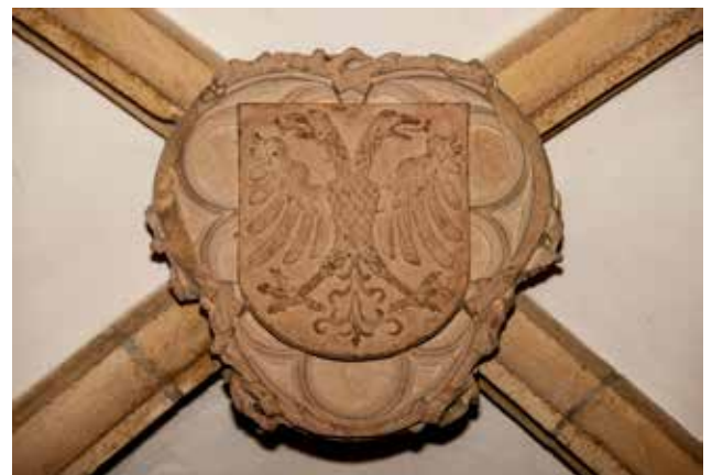
Abb. 5: Schlussstein am Gewölbe des Breisacher Lettners.
