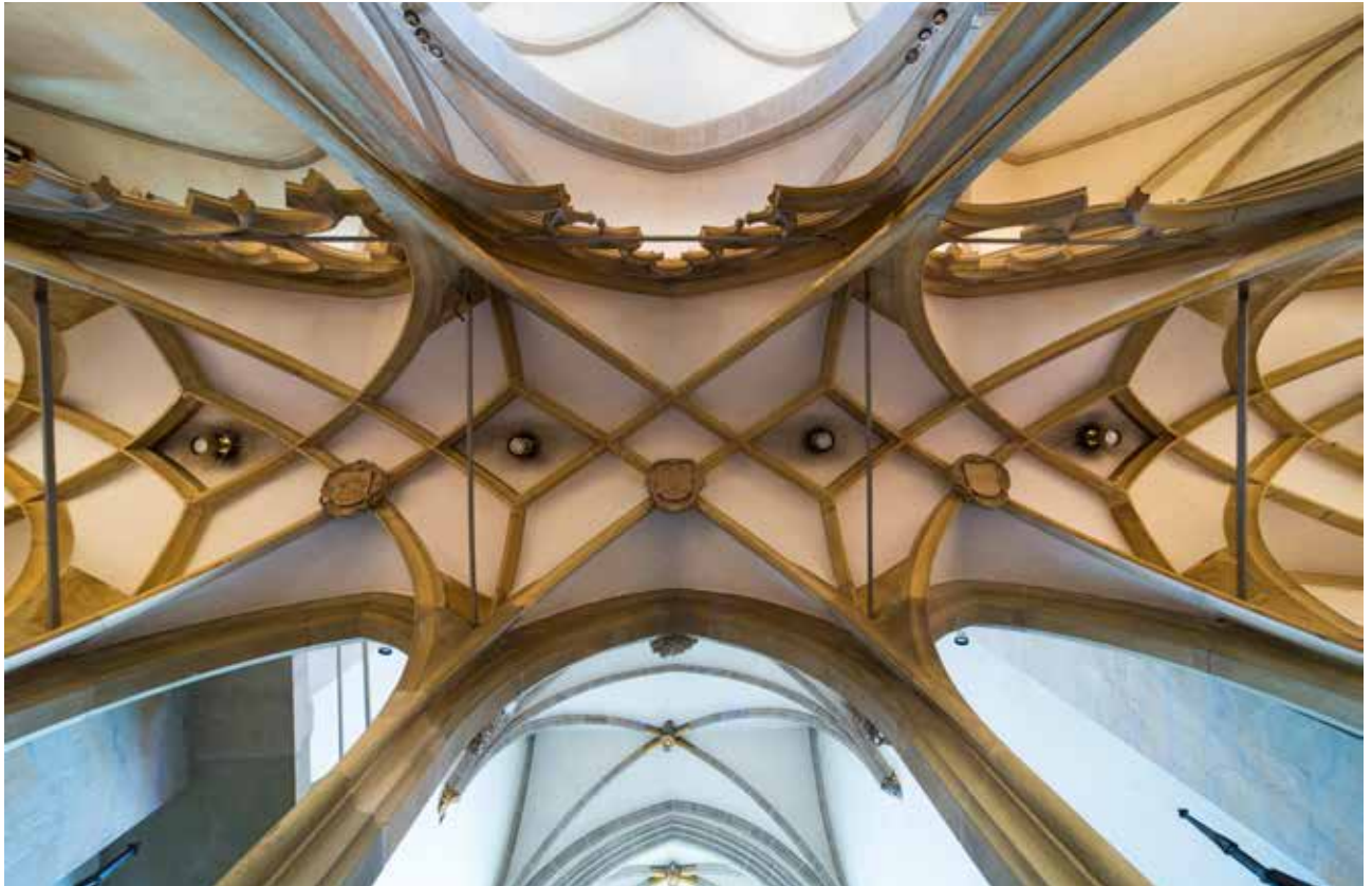
Abb. 4: Gewölbe im Lettner.
