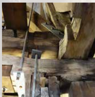
Auftretende Kräfte sollen von Stahlstangen abgeleitet werden. Die Stahlstangen durchziehen den Glockenstuhl über alle drei Geschosse.
