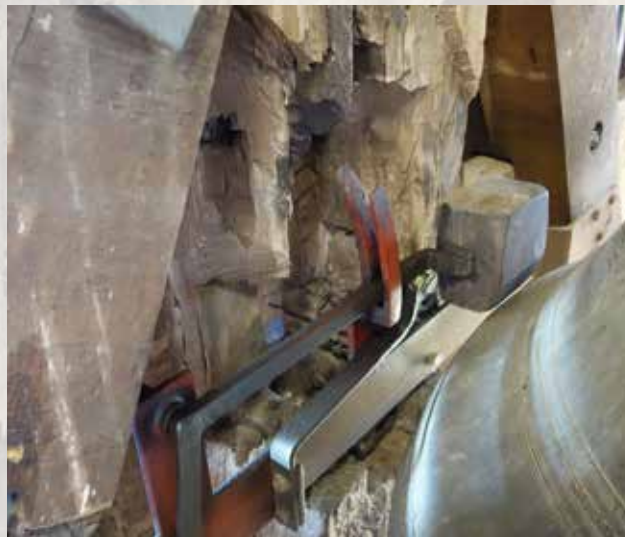
Auftretende Kräfte sollen von Stahlstangen abgeleitet werden. Die Stahlstangen durchziehen den Glockenstuhl über alle drei Geschosse.
