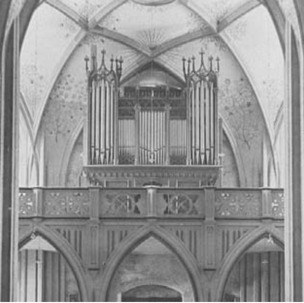
Orgelempore in der Westhalle vor 1930
