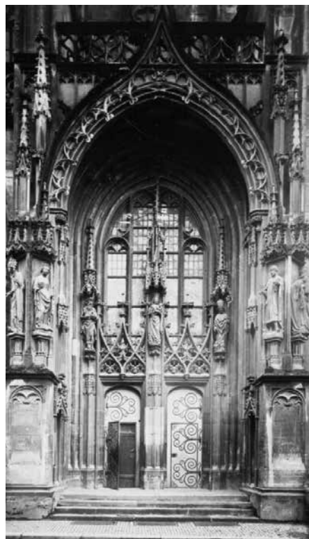
Abb. 32: Thann Nordportal Bildarchiv Foto Marburg
