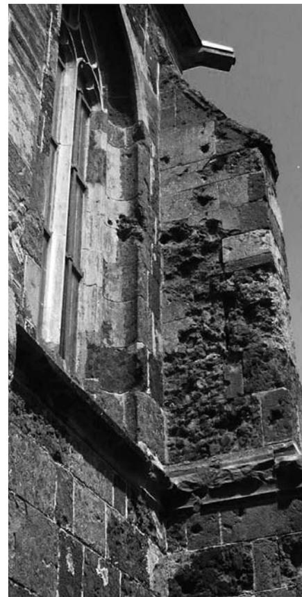
*Sakristieanbau mit stark geschädigten Sand- und Tuffsteinen. Das Bild wurde 2004 aufgenommen*
