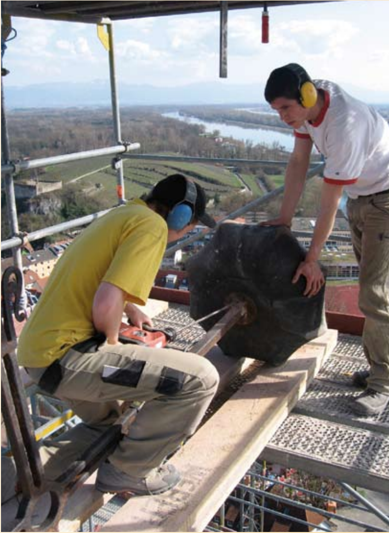
Südturm: Das in die Turmkugel eingebleite Kreuz wird mühsam aus dem Stein herausgebohrt (links Paul Ahl, rechts Philliph Adam, Steinmetze der Firma Hellstern)
