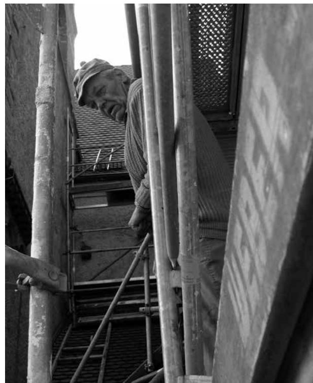
Es ist wie bei jeder aus Stäben, Brettern u. Ä. bestehenden Konstruktion. Wird sie belastet, benötigt sie stabilisierende Elemente wie etwa Diagonalstäbe. Dass das Münster Strebepfeiler und andere vorstehende Formen besitzt, hilft der Gesamtstabilität des Gerüsts, denn solche Formen zwingen den Gerüstbauer zu Kröpfungen, die der Konstruktion zusätzlichen Halt geben. Wichtig sind dabei auch die in den Mauerwänden verankerten Dübel: Sie stabilisieren das Gerüst in der Horizontalen.
