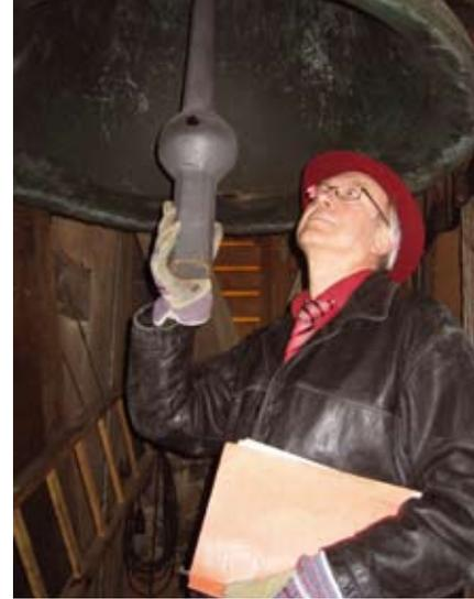
Bild 1: Glockeninspektor Kurt Kramer prüft den Anschlag und die Lagerung des Klöppels
