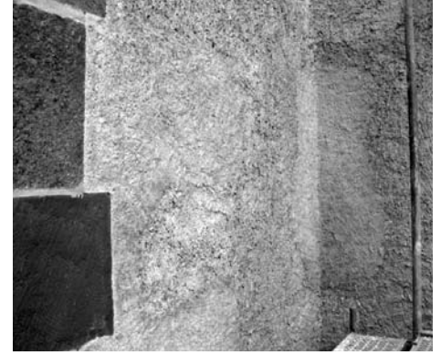
Gleiche Zone mit überputzten Tuffsteinen
