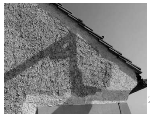
Putzausbesserung am Westgiebel
