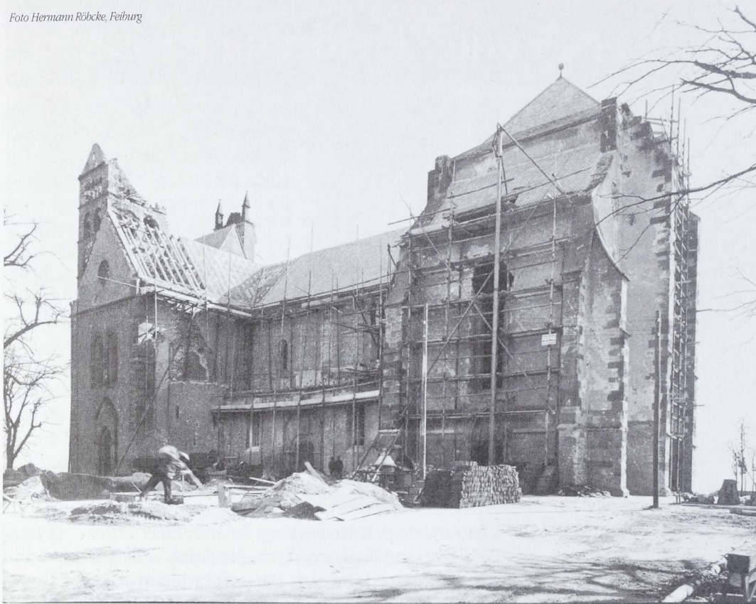
Das Münster im Winter 1945/46. Die Dacheindeckung ist fast fertig gestellt. Im Vordergrund ein Teil des Baubolzes, von dem Seite 8 die Rede ist. Der Dachhelm des Aufgangs zur Orgelempore (rechts neben dem Querbaus) ist abgerissen: Er erhielt beim Neuaufbau eine andere Form. Der Vorgängerturm ist rechts oben dargestellt.
