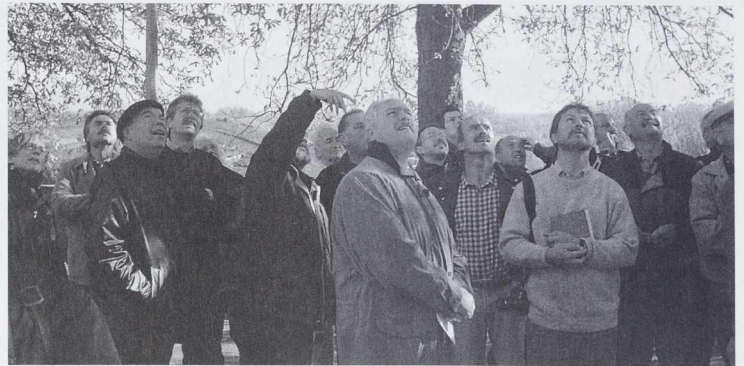
O. WÖLPERT vom Landesdenkmalamt erläutert den Teilnehmern die Steinschäden am Münster. Vorne Mitte Bürgermeister G. SCHWEIZER, links (mit Baskenmütze) der Baudezernent des Erzischöfl. Ordinariats, DR. M. KREMER.
