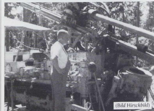
Auf Raupen fahrende Steinbohrmaschine
