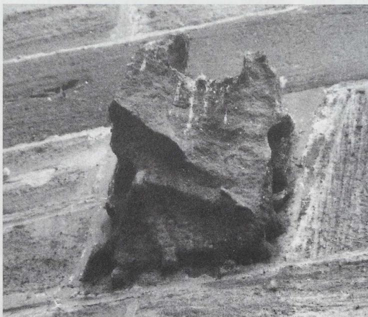
Abb. 4: Abgeschlagener Wasserspeier auf der Südseite des Hochchores
