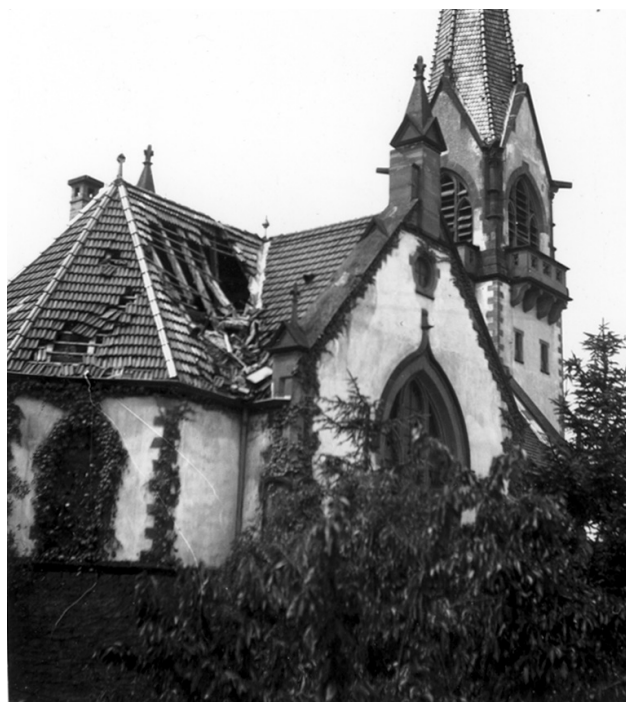
31. Oktober 1944: Die evangelische Kirche ist nach Artilleriebeschuss beschädigt. Bild W. Langer
