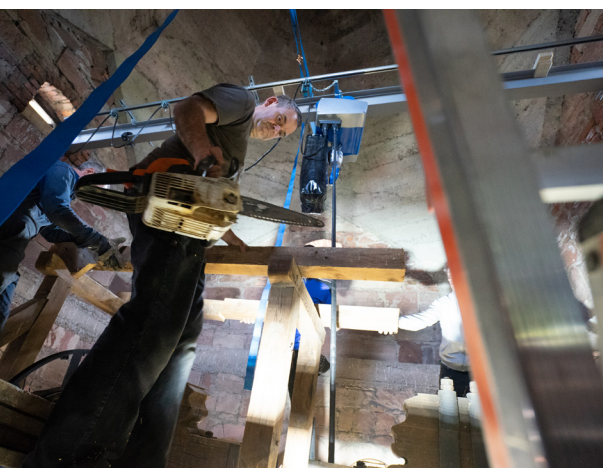
Demontagearbeiten im 3. Geschoss am 16. April
