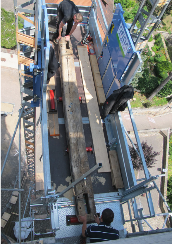
Transport eines demontierten Balkens im Lastenaufzug
