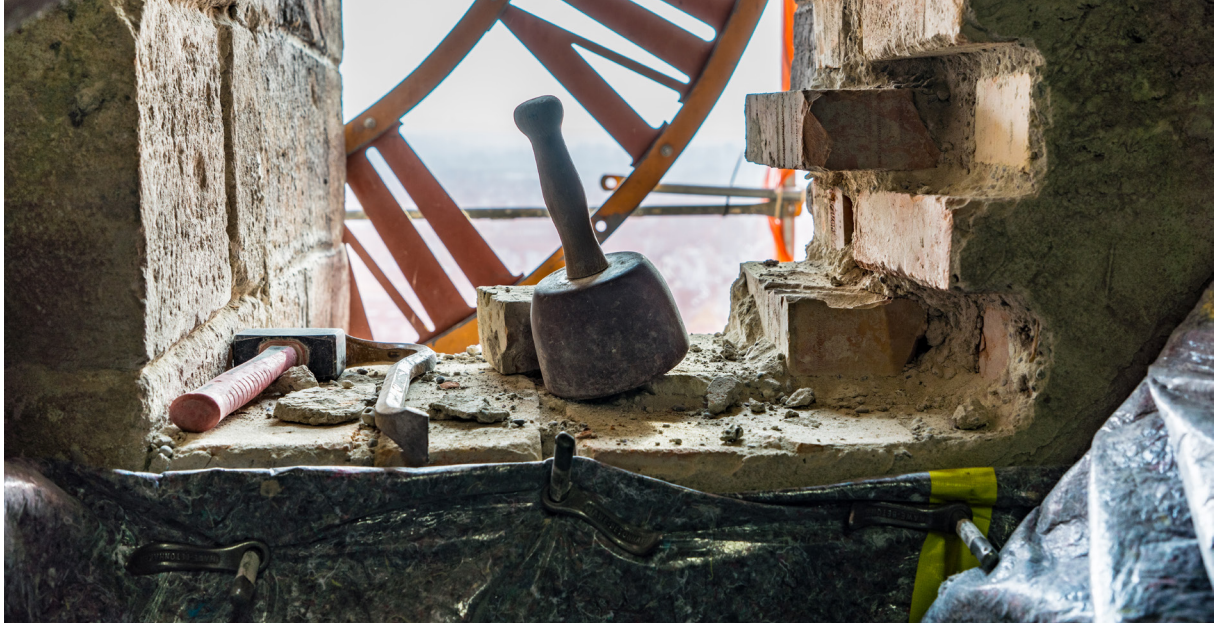
27. März 2018 - Steinmetze der Firma Hellstern entfernen Vermauerung im Arkadenfenster
