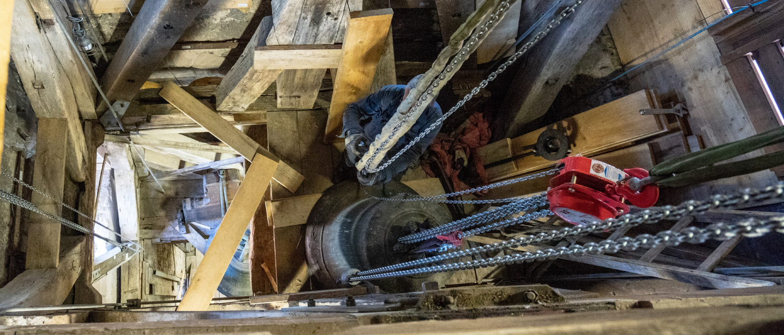
19. April 2018 - Firma Schneider demontiert im Nordturm Glocken und Glockentechnik
