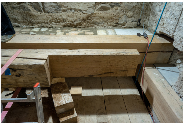
15. November 2018 - Balkenbasis in Bearbeitung
