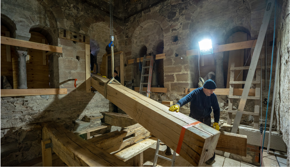
6. November 2018 - der erste der beiden neuen Balken für die Glockenstuhlbasis wird in den Turm eingebracht
