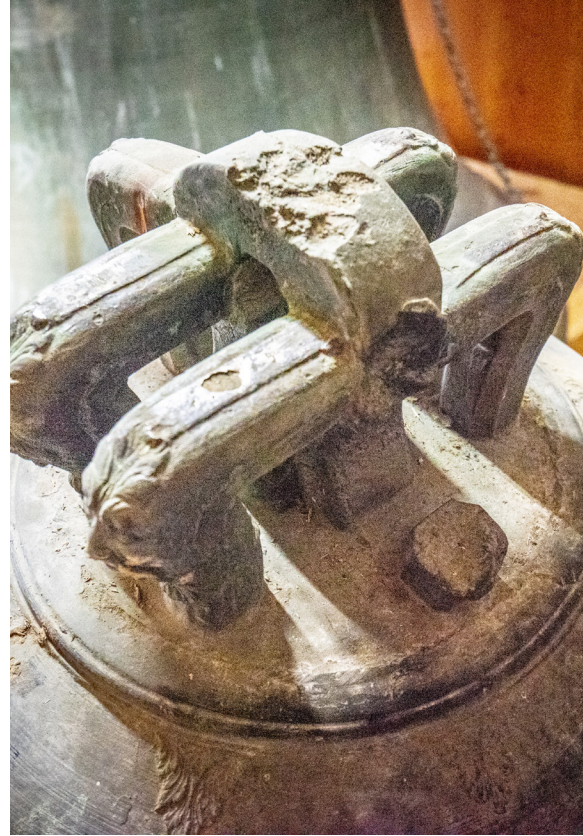
Beschädigte Glockenkronen der großen Nürnberger Glocke
