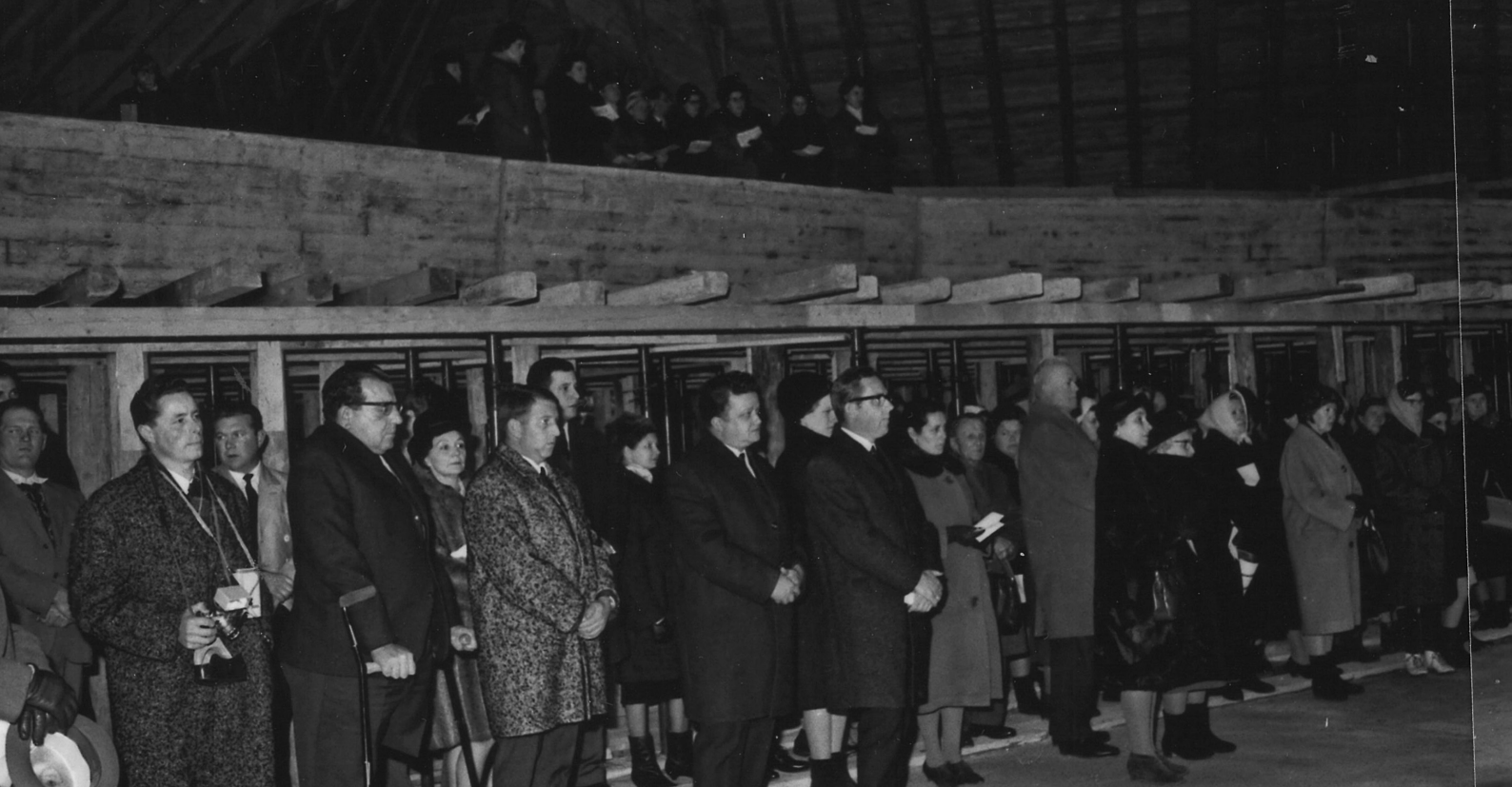
Feierliche Grundsteinlegung am 22. Dezember 1967
