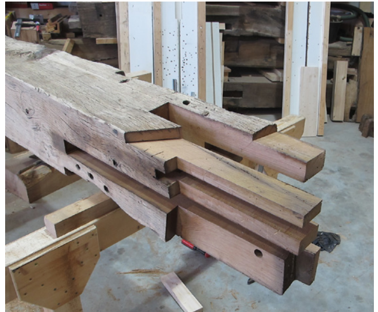
Abb. 5 : Balken von 1584, alle schadhafte Stellen sind sorgfältig entfernt
