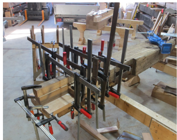
Abb. 7 : Balken von 1584, schrittweises Anleimen der "Holz-Prothesen"
