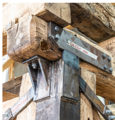
Abb. 14 : Detail der Stahlhilfskonstruktion
