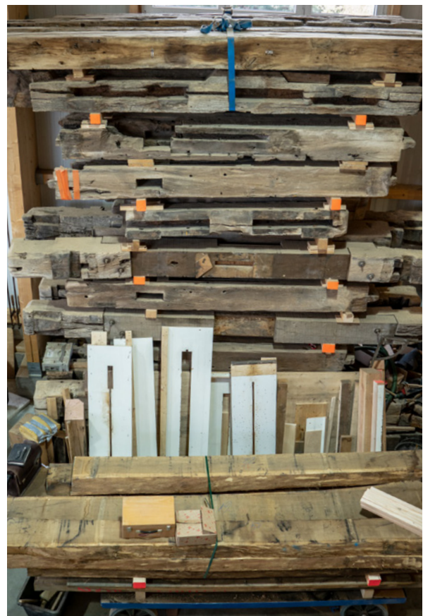
Abb. 6 : vollständig zerlegter Glockenstuhl
