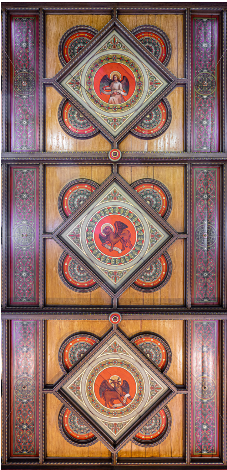
Die Holzkassettendecke von 1883/84
