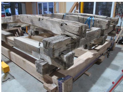
gereinigte Schwellen vor der Bearbeitung
