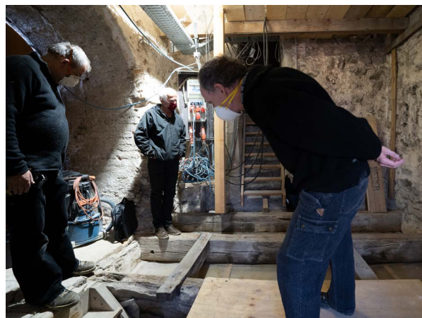
Freigelegte Balkenlage aus dem 12. Jahrhundert unterhalb der Glockenstube
