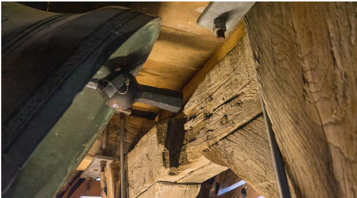
Gefährliche Kollisionsgefahr vor der Sanierung
