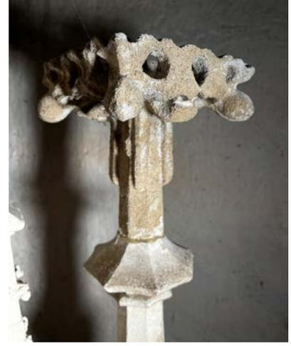
Abb. 8: Für den Ersatz verloren gegangener Steinteile wurde in einer früheren Maßnahme Pfaffenweiler oder Rouffacher Sandstein verwendet. ©Hans Leisen
