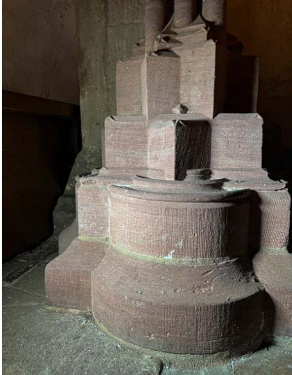
Abb. 4: Der Sockel des Fußes aus rotem Sandstein setzt sich aus zwei Werkstücken zusammen, die mit einer Zementmörtelfuge verbunden sind. Der obere Teil ist ergänzt, was sich an der Steinbearbeitung sehen lässt. © Hans Leisen
