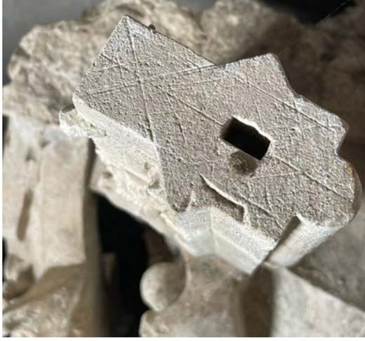
Abb. 6: Konstruktionsritzungen auf der Fuge eines Werkstückes.
