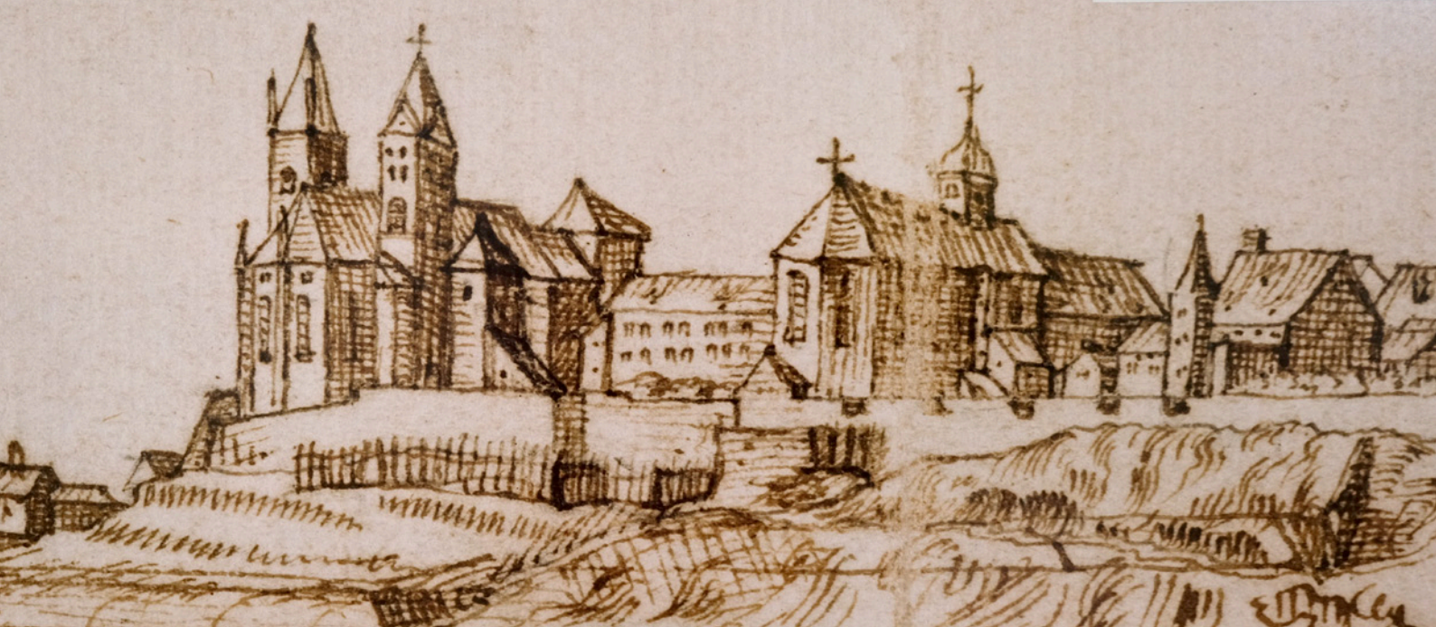
Abb. 1: Aus dem Stadtmuseum Breisach, gezeichnet vom Architekten J.J. Arhardt. Die Klosterkirche (Mitte des Bildes) in typisch schlichter Bettelordenbauweise: keine dekorativen Elemente am Chor, statt eines Turmes nur ein kleiner Dachreiter.
