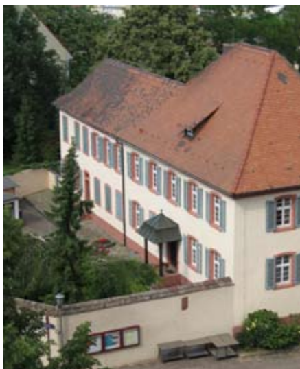
Blick auf das Pfarrhaus vom Münstergerüst aus.
