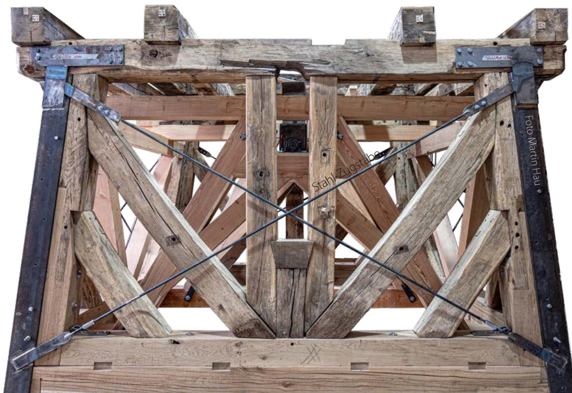
Abb. 6 Basisgeschoss – durchlaufende Schwellenlage
