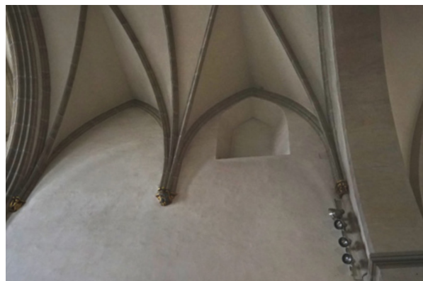
Abb. 7b: Südliche Chorwand mit dunkler Schmutzablagerung und hellem Überhang als Ausbruchspur des Schildbogens eines früheren Chorgewölbes in der Form eines gedrückten Spitzbogens.
