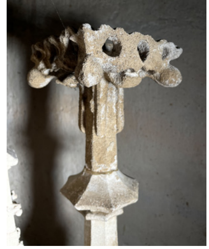
Abb. 8: Für den Ersatz verloren gegangener Steinteile wurde in einer früheren Maßnahme Pfaffenweiler oder Rouffacher Sandstein verwendet. ©Hans Leisen
