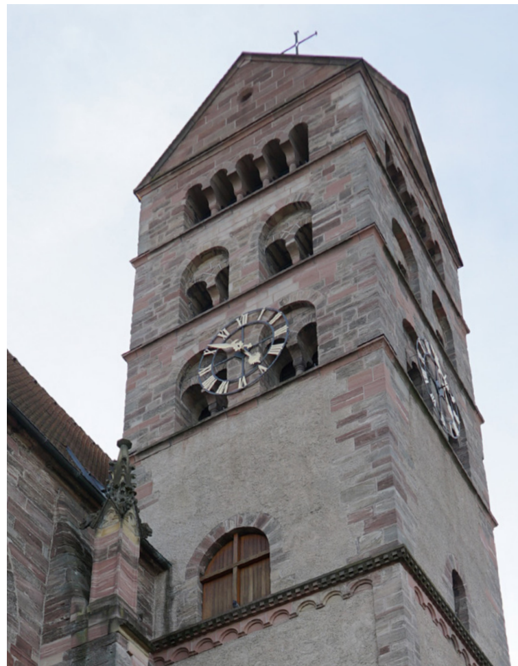
Abb. 10: Bei den unteren Geschossen des Nordturms sind nur Ecken, Öffnungen und Gesims aus Werkstein, das Mauerwerk dazwischen aber aus Bruchstein hergestellt, wogegen die drei Glockengeschosse einen vollflächigen Werksteinverband aufweisen.
