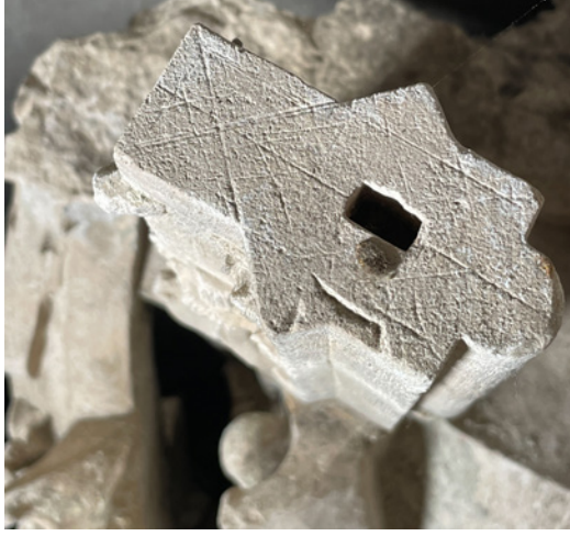
Abb. 6: Konstruktionsritzungen auf der Fuge eines Werkstückes.
