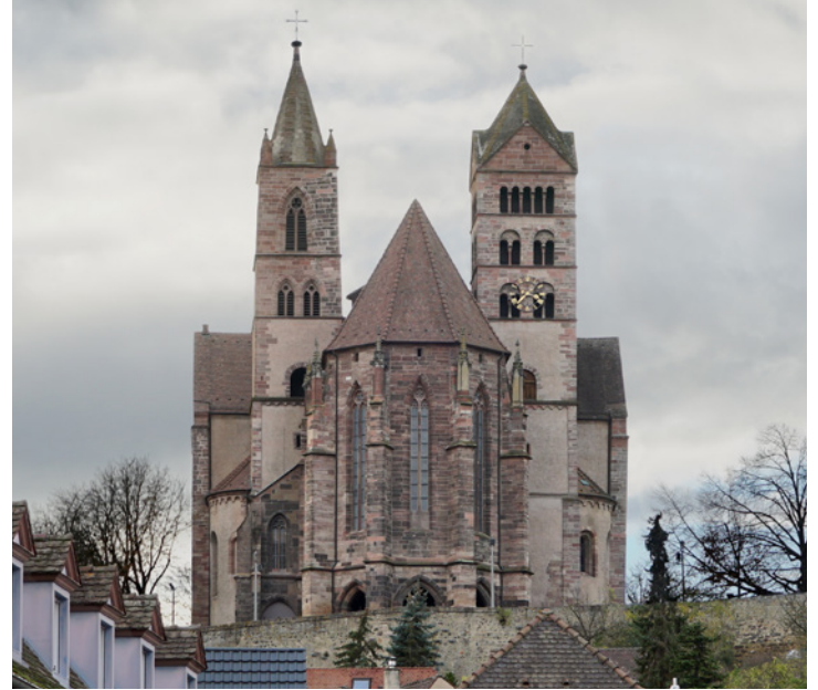
Abb. 9: Beim Blick aus der Unterstadt wird deutlich, dass sich die beiden Türme über die Höhe der unteren drei Geschosse gleichen, wogegen die Glockengeschosse nicht nur unterschiedlich aufgebaut sind, sondern zwei Baustilen - Spätromanik und Gotik - zuzuordnen sind.
