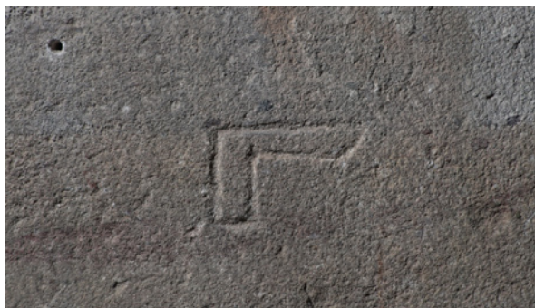
Abb. 11: Eines von fünf gleichen Steinmetzzeichen im zweiten Glockengeschoss in der Form eines Steinmetzwinkels von stark gedrungener Form.
