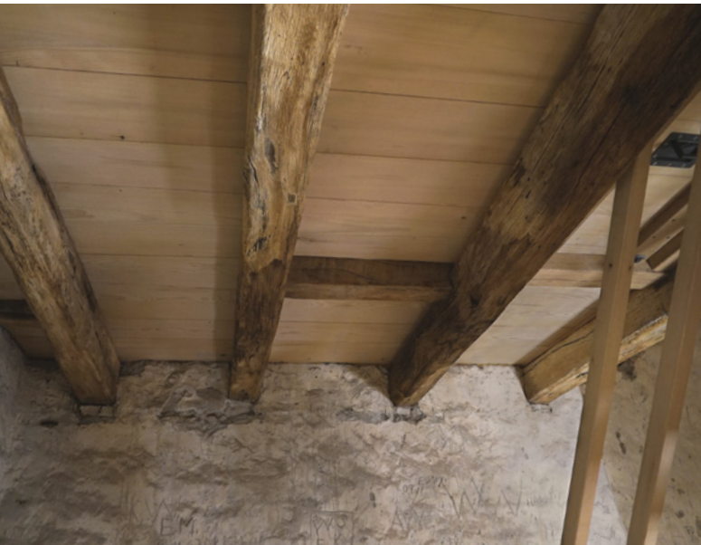
Abb. 2: Balkenlage im aktuellen Zustand mit neu aufgelegtem Belag; Blick nach Westen.
