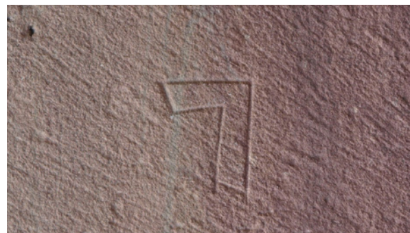
Abb. 12: Steinmetzzeichen gleicher Ausprägung wie in Abb. 11, das zahlreich am Freiburger Münster an den westlichen drei Jochen des nördlichen Seitenschiffs auftritt.
