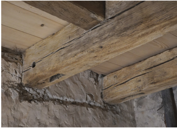
Abb. 4: Östliches Ende der beiden südlichen Balken mit jeweils einem Zapfenloch an der Unterseite mit schräg verlaufenden Schmalseiten, sowie horizontaler Holzdübel im Balken rechts und von einem solchen verbliebene Bohrung im Balken links.
