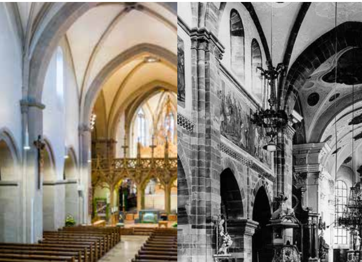
Abb. 13: Wandaufbau des Kirchenschiffs des Breisacher Münsters und des Kirchenschiffs von St. Cyriacus in Altdorf (Altorf) im Elsass im Vergleich.
