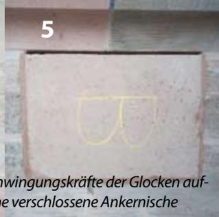
Acht Ankerbolzen werden die Schwingungskräfte der Glocken aufnehmen. Hier eine offene und eine verschlossene Ankerbolzenische
