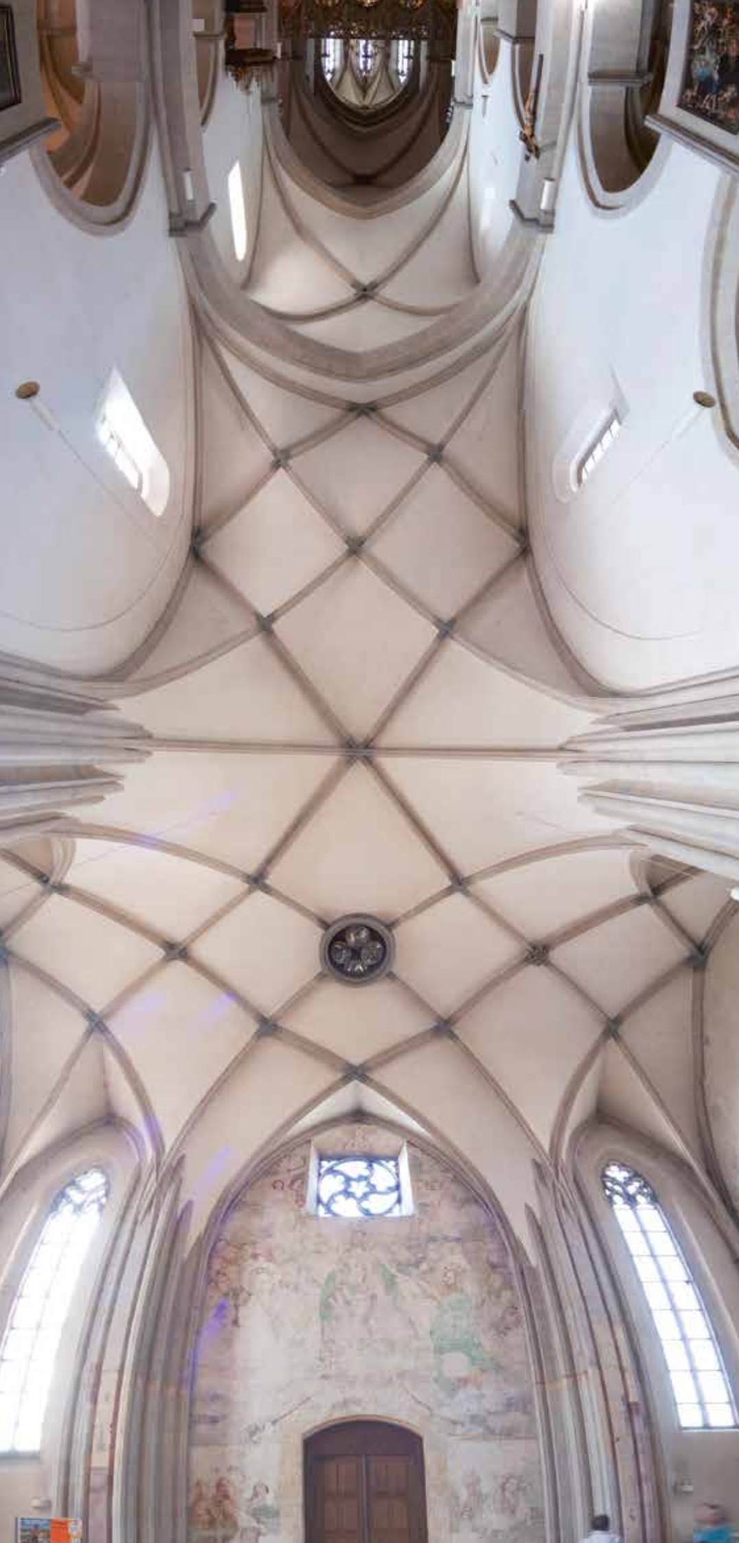
Abb. 27 Blick in das Gewölbe der Westererweiterung - Foto: Martin Hau
