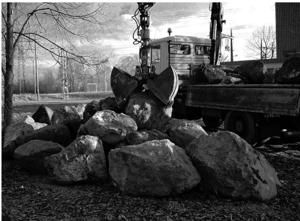
Werksteinblöcke im Zwischenlager. Von den insgesamt 570 m 3 gelösten Steinen wurden 130 m 3 für die Weiterverarbeitung ausgewählt
