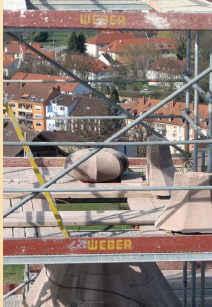
Nordturm: Demontierte Turmspitze ohne Kreuz
