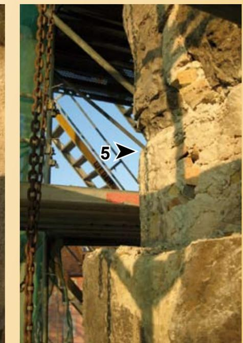
Pfeil 5: Fast bis zur Hälfte ihres ursprünglichen Volumens erodierte **Kantensteine**. Sie wurden komplett ersetzt.
