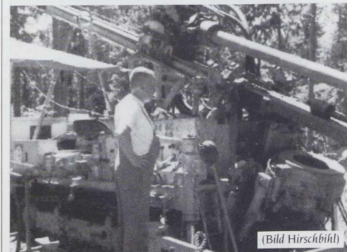
Auf Raupen fahrende Steinbohrmaschine
