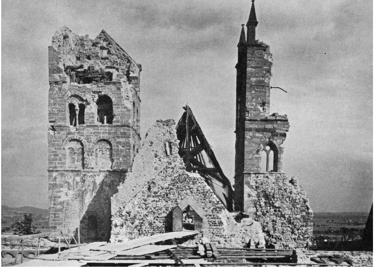
Blick Richtung Osten auf den Hochchor und die zerstörten Türme. Aus dem Nordturm ragt der beschädigte Glockenstuhl heraus
