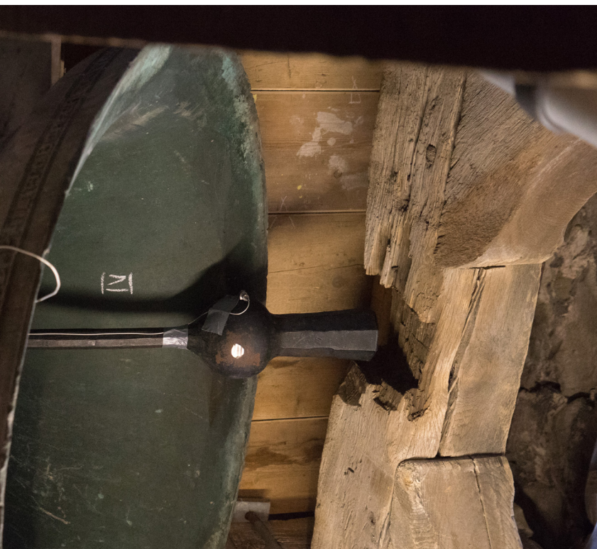
Das Gebälk wurde an dieser Stelle ausgespart, um Platz für den schwingenden Klöppel zu schaffen.
