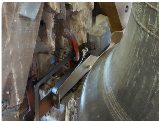
Bild 5: Einbauten und Umbaumaßnahmen an der Läutetechnik
