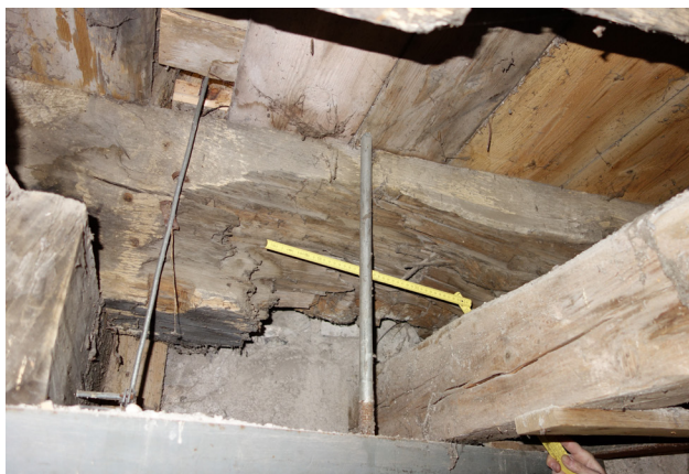
Bild 2: Eichenbalken Basis unterhalb der Ebene 1
