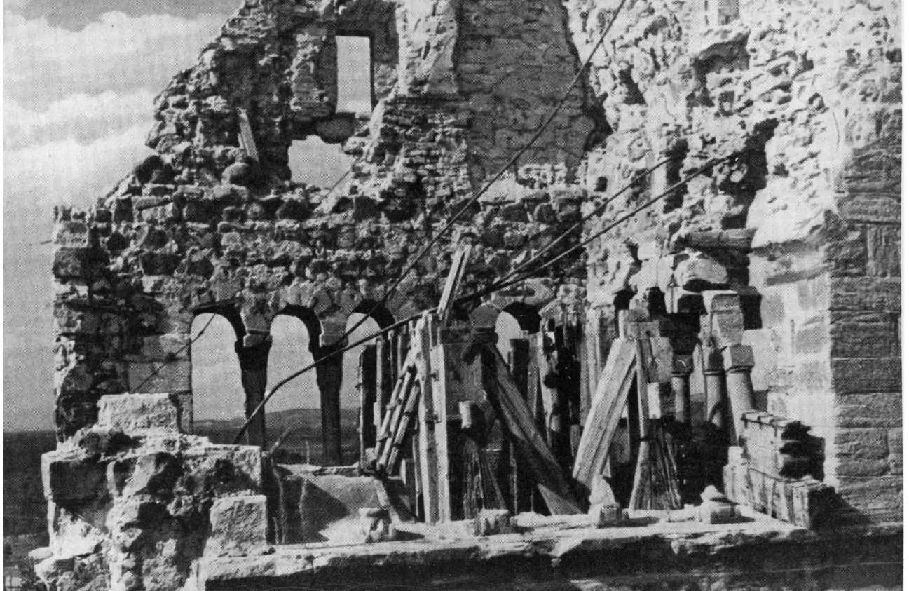
Bild 4: Zustand nach der Bombardierung, Holzteile des Glockenstuhls Nordturm
