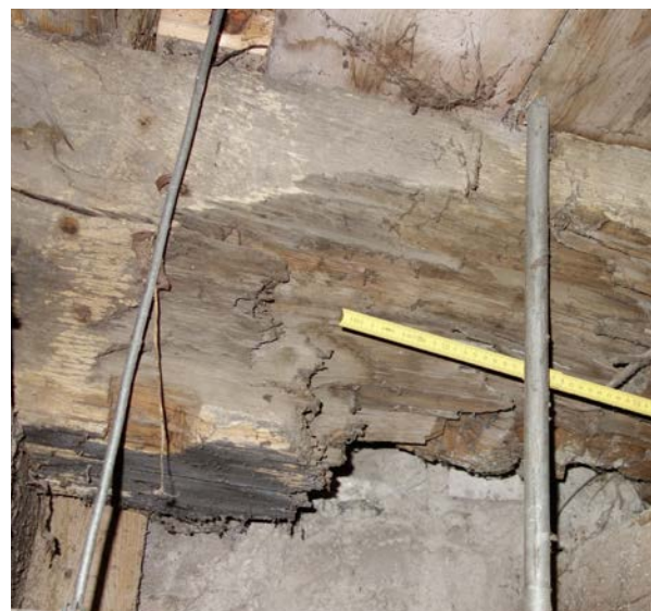
Glockenstuhlbasis: Eichenbalken unterhalb der Ebene 1
