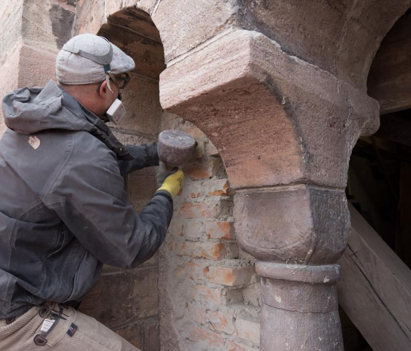
Abb 1 - 27. März 2018 - Die Steinmetze der Firma Hellstern öffnen die vermauerten Arkadenfenster am Nordturm
