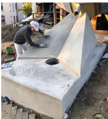
Eines der vier erneuerten Fundamente
