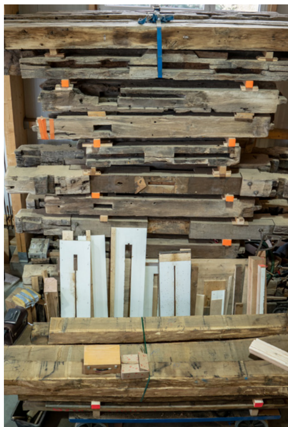
Abb. 6 : vollständig zerlegter Glockenstuhl
