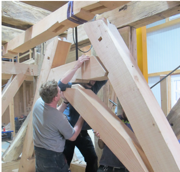
Abb. 3 : Aufrichten des ersten Glockenstuhlstockwerkes bzw. des Gefachs für die TubaDei
