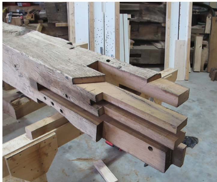
Abb. 5 : Balken von 1584, alle schadhafte Stellen sind sorgfältig entfernt
