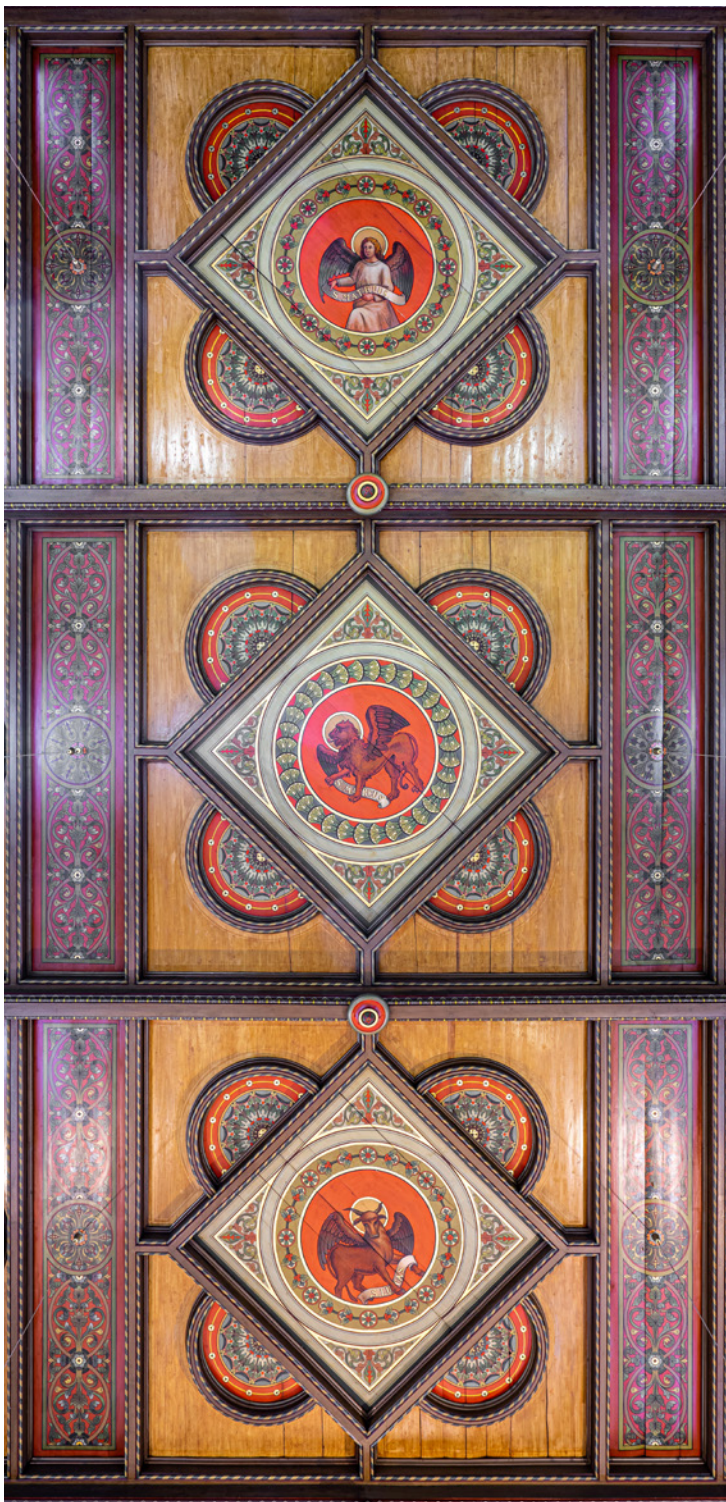
Die Holzkassettendecke von 1883/84
