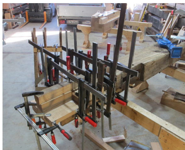
Abb. 7 : Balken von 1584, schrittweises Anleimen der "Holz-Prothesen"
