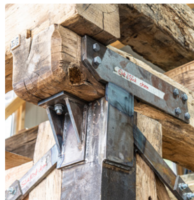
Abb. 14 : Detail der Stahlhilfskonstruktion
